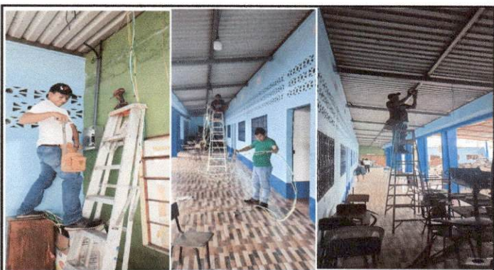
Foto 4: Reparación del sistema eléctrico
