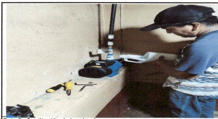
Foto 5: Sustitución de bomba de agua
