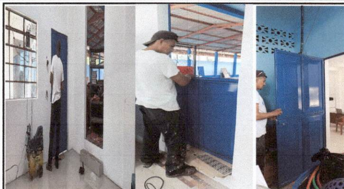
Foto1: Sustitución de puertas
