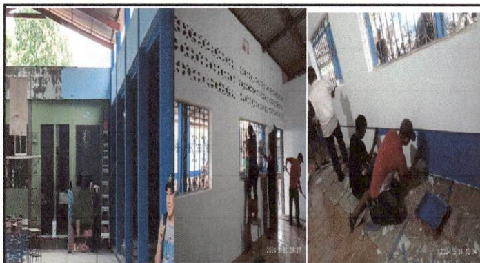
Foto 3: Pintura de muros exteriores e interiores de toda la escuela
